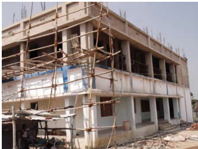
De leer- werkplaats in aanbouw.
